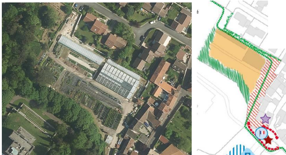
Le site des serres dans son environnement urbain
