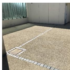
Béton drainant et poreux
