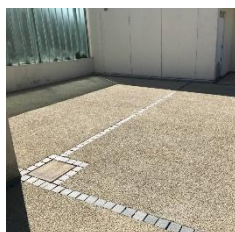
Béton drainant et poreux
