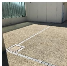
Béton drainant et poreux
