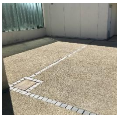
Béton drainant et poreux
