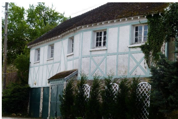
N°15 : Bâti, 5 rue du Grand Morin
