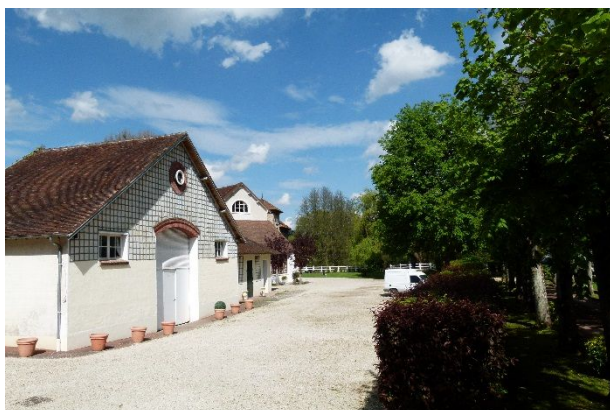
N°5 : Bâti « Manoir de Tigeaux », Rue du Grand Morin
