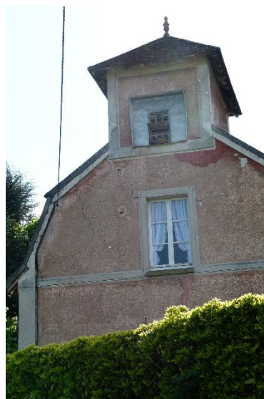
N°16, 17 et 19 : Ensemble Bâti dont Château, rue de la forêt
