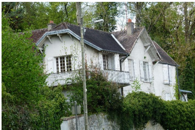
N°7 : Bâti, 37 rue du Grand Morin
