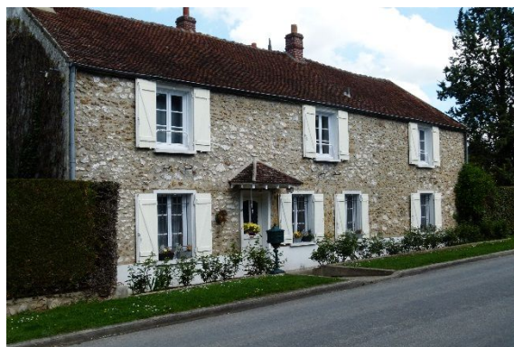
N°14 : Bâti, 10 rue du Grand Morin
