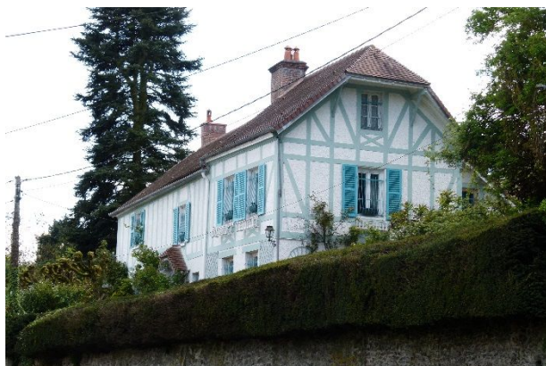
N°13 : Bâti, 7 rue du Grand Morin
