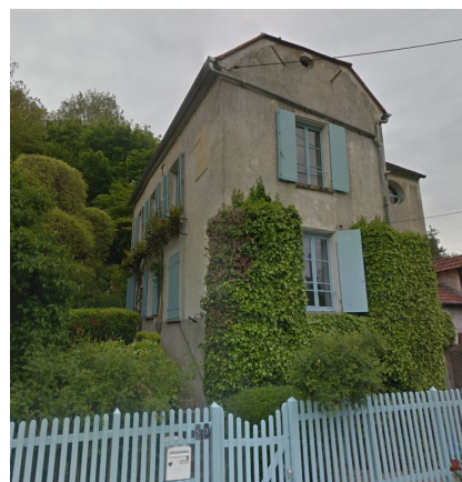
N°6 : Bâti, 53 rue du Grand Morin
