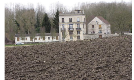
Les bâtiments restants du Grand Moulin
