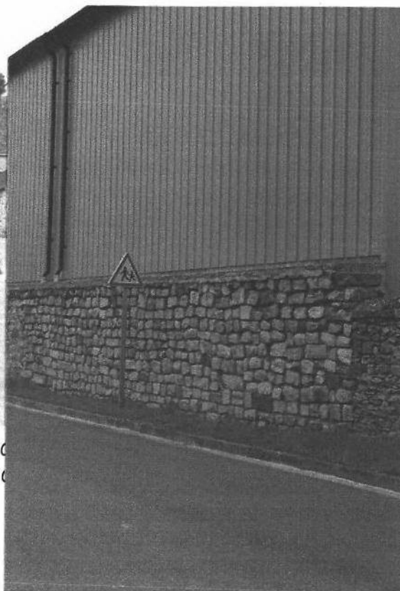
Le hangar a fait place à un mur en bardage. Un mur en bardage. Cela dit, l'insertion paysagère de ce mur dans les perspectives sont impossibles. La ferme de Courtry au centre bourg.
