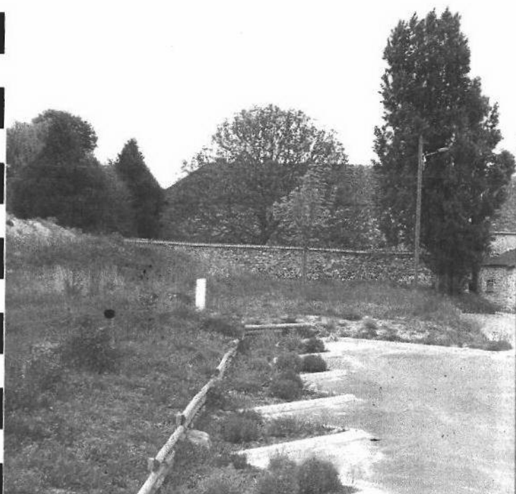
Depuis la rue de la Ferme. La toiture de l'aile occidentale continue dans la perspective. Les éléments externes à la ferme
