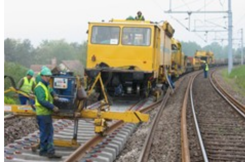
Longs Rails soudés sur traverses béton
