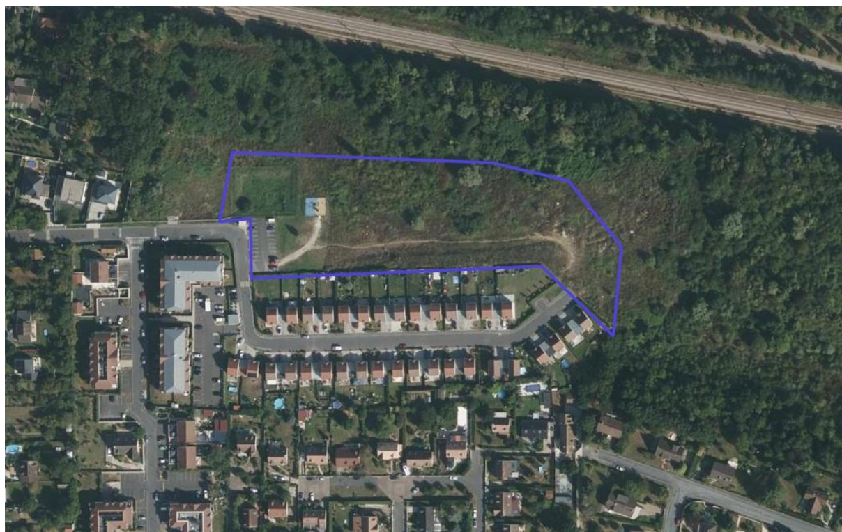
Figure 8 : Vue aérienne du secteur n°3 (IEA)
