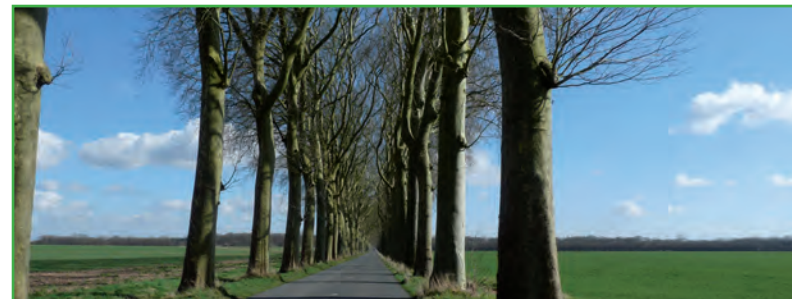
Portion de la RD 215 classée au MH (arrêté 26/12/94) Photographie : Atelier Anne Tessier
