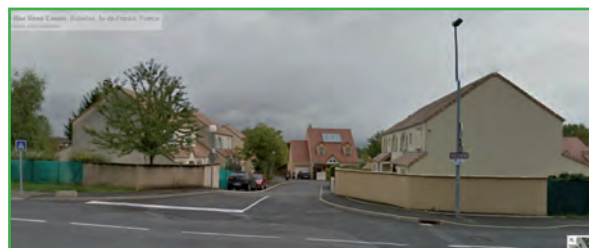
Maisons de la résidence Villas du Moulin (7) Photographie : Google Street View, 2009
