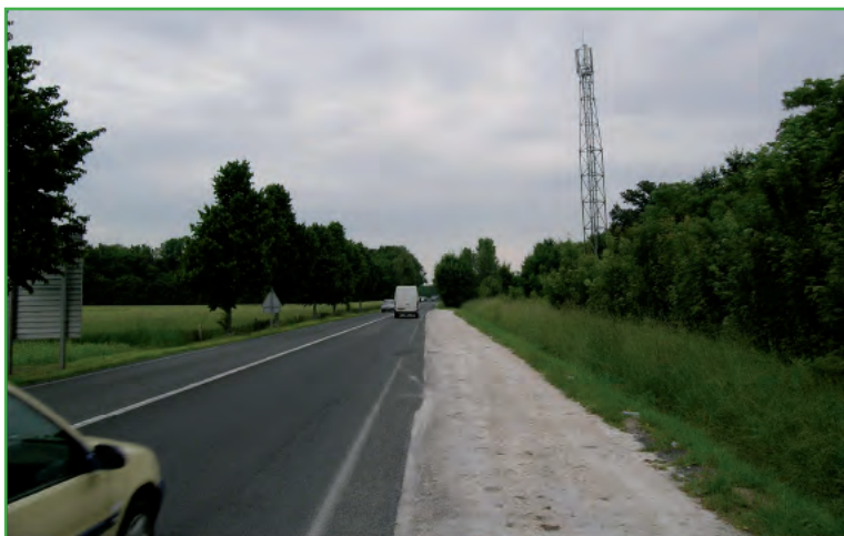
1- Route de Lagny (RD 471) - Vue vers le nord Bas-côté en stabilisé
