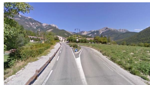
Lot central en entrée de village
