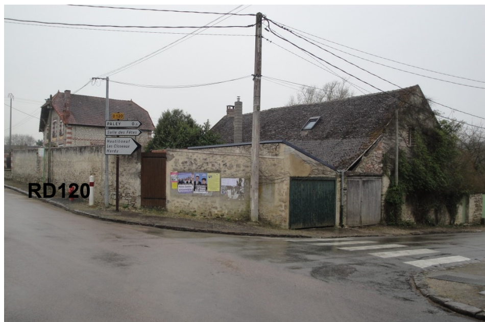
Exemple de carrefour à traiter : rue du Gault / RD 69 (photo sur site).
