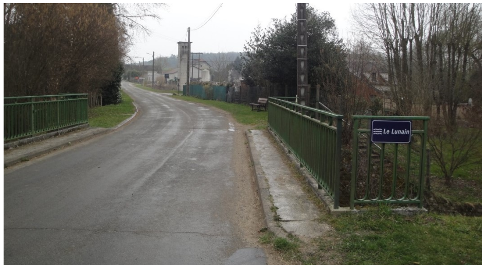
PALEY : Exemple de franchissement du Lunain en entrée de village (source : photo sur site).
