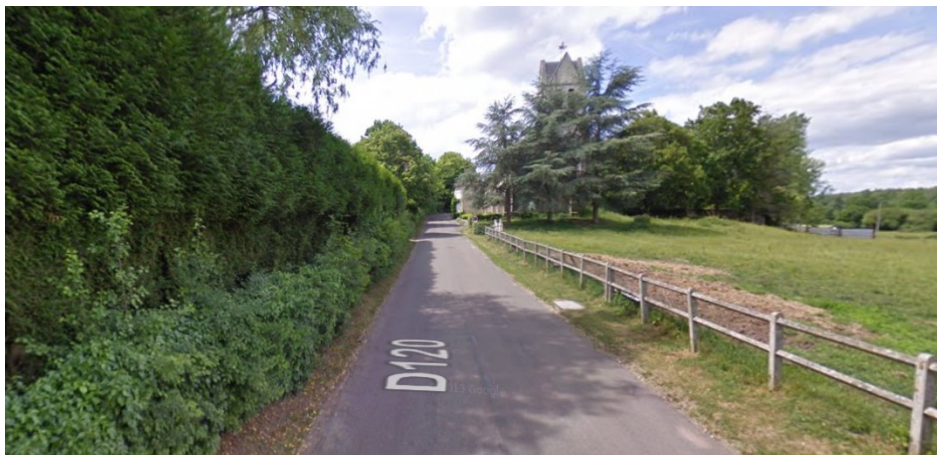
PALEY : Tronçon d'itinéraire extra-urbain, passant pour la RD 120 en direction de Paley (l'Eglise) : les cheminements piétons mériteraient d'être mieux pris en compte (source : Google Street View).
