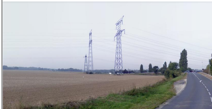
Les lignes haute tension sur le plateau agricole
