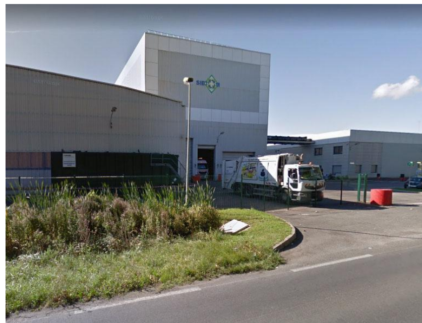
Unité de valorisation des ordures ménagères d'Ozoir-la-Ferrière
