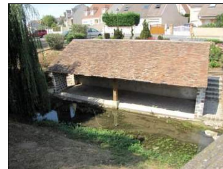
Le lavoir situé en bordure de la rivière. Restauré et accessible, il est toujours un lieu de rencontre
