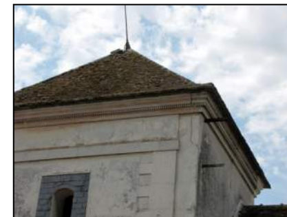
Détails du pigeonnier de la ferme de Condé. Une architecture simple et harmonieuse. Identité régionale
