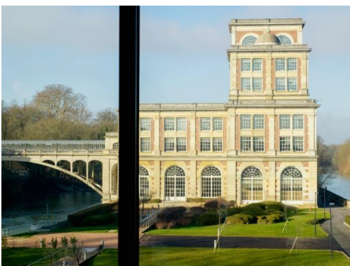
Bâtiment Cathédrale et le Pont Hardy
