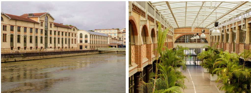
Bâtiment Colonnades, vues d'extérieur et d'intérieur
