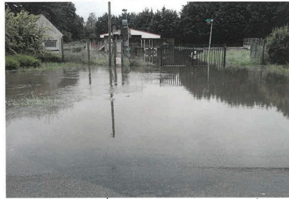
La Station d'épuration Route de Heaux
