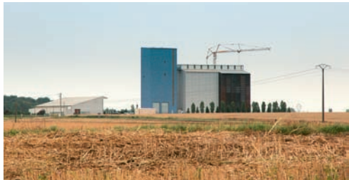
3. Lorrez-le-Bocage L'implantation et la qualité architecturale des bâtiments agricoles ou industriels de grande taille est à soigner. Pour cela, il est nécessaire de prendre en compte la capacité du lieu à accueillir ces équipements, sans pour autant vouloir masquer leur masse derrière un écran végétal qui contribue plutôt à affadir la plastique et la dynamique que peuvent apporter de telles constructions.
