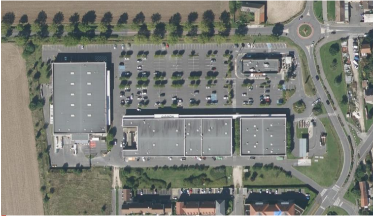
Zone commerciale des Roches
