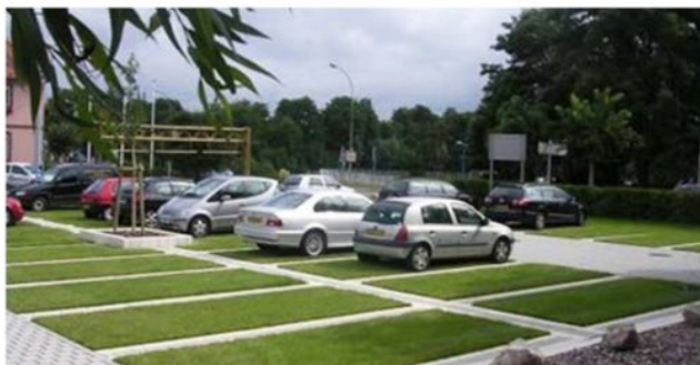
Produits EcoVegetal : pelouse pour faible usage, végétation résistante (mousse, sedum, ...) pour usage modéré
