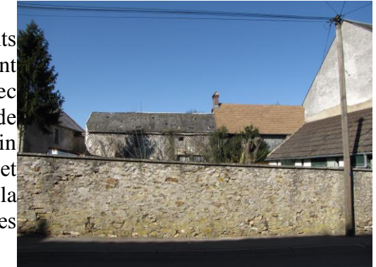
Ancien mur aux matériaux en accord avec le bâti ancien.
