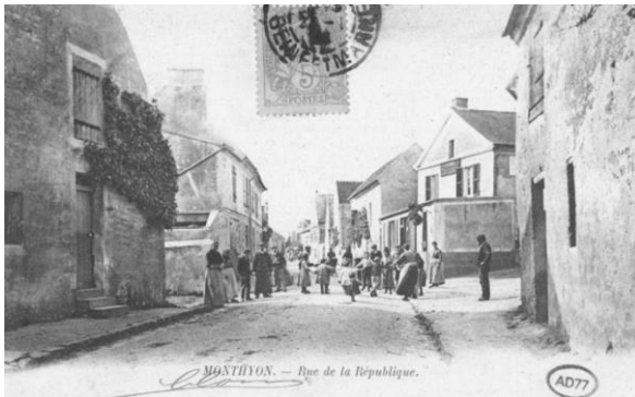
Implantation dense en alignement sur rue dans le bourg ancien. Carte postale vers 1900.
