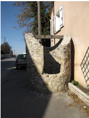
Puits encore visible et assez bien conservé, en bordure de la Rue des Moulins.
