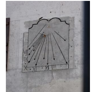
Ancien cadran solaire ayant été préservé lors d'intervention sur la façade. Élément fragile.
