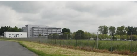
Bureaux Snecma – Safran Construction en cours d'un bâtiment R+1 en premier plan
