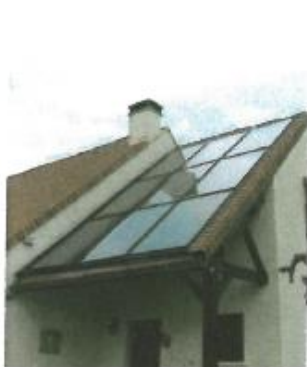
sur la totalité du versant d'un volume annexe
