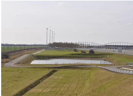
Bassin de rétention, le long de l'autoroute A5
