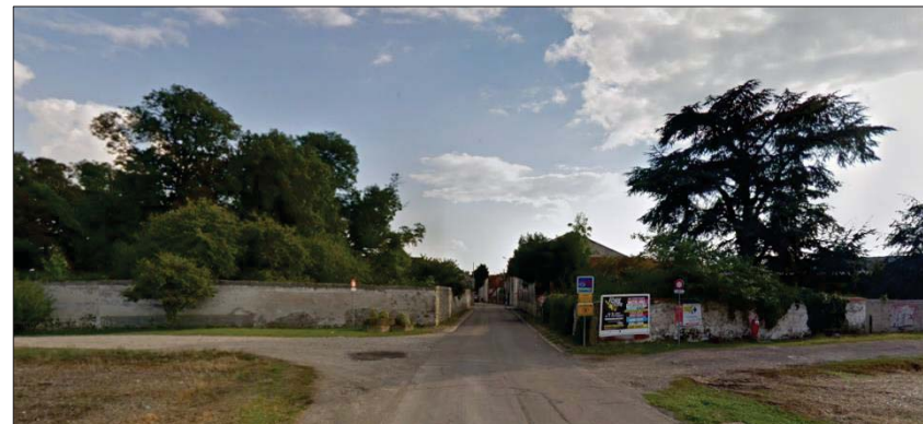
Entrée Nord et son seuil d'entrée à l'image des grands parcs : hauts murs de pierres et végétation arborée.
