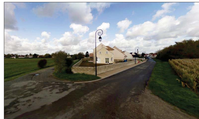
Entrée par la rue Bardin et rue des Houches : une pointe construite s'avancant vers la plaine.
