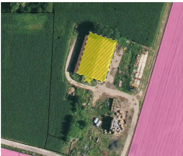
Nouvelle installation agricole
