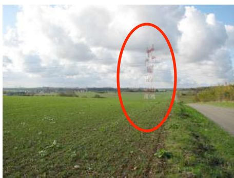
Un pylône électrique haute tension
