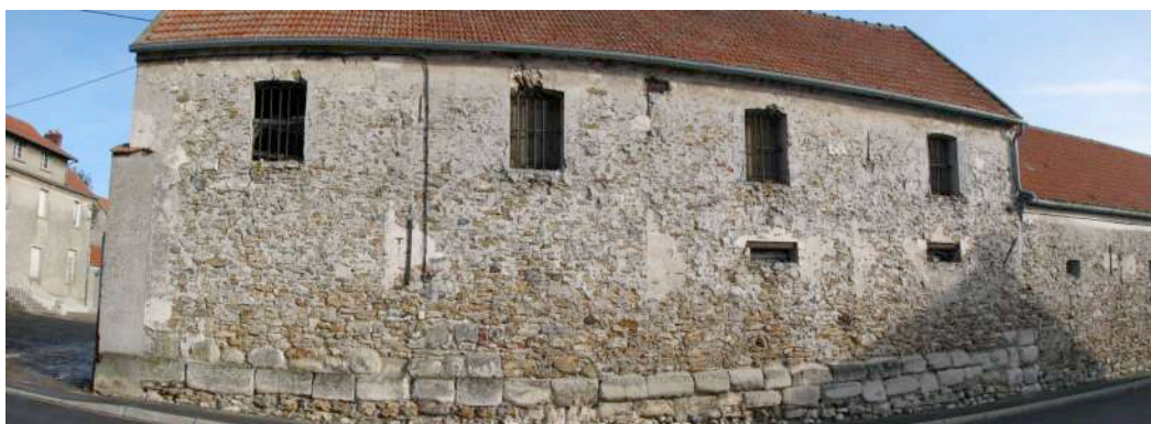
La ferme du Vivier, rue du Vivier
