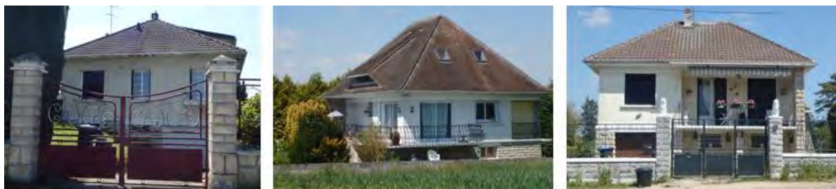
Logements dans constructions typiques des années 1960
