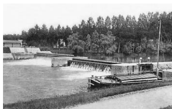
Ecluse de la Marne-XXème siècle
