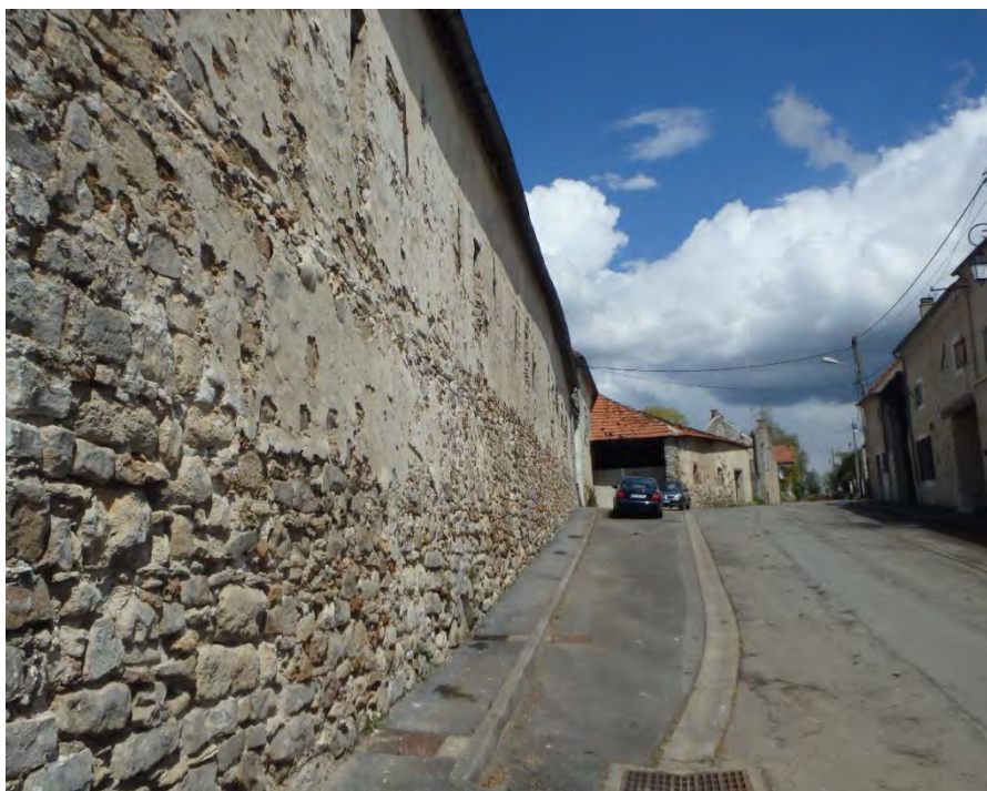
Stationnement le long de la voie rue du Château environ 6 places
