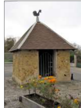
La fontaine du toit parfaitement restaurée.
