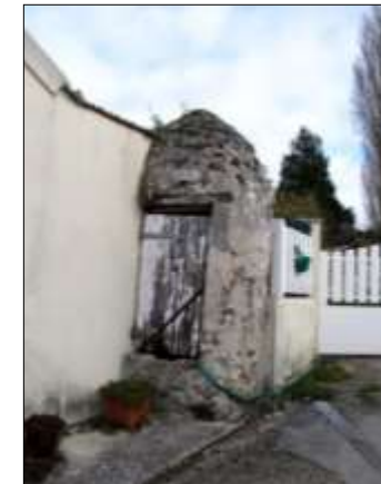
Puit traditionnel situé dans une cour commune livré aux soins des riverains.
