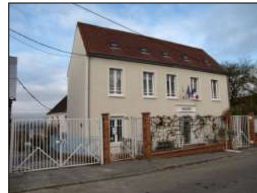
La Mairie actuelle à la façade sobre
