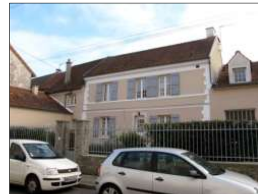
Maison rurale typique. Rue de la Fontaine du Toit. L'appartenance à un style régional permet aussi une cohésion communale.
