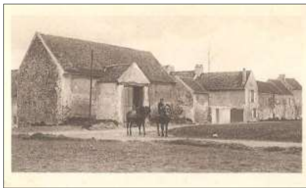
La grange à porche monumental au début du XXème siècle. Ouvrage majestueux s'ouvrant sur la campagne des Basses fermes
