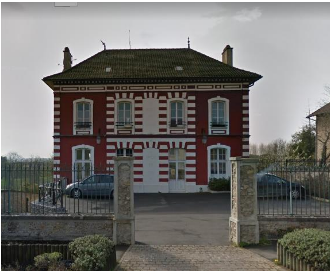
Ancienne école et mairie, construction d'intérêt architectural (au Sud de la rue de l'Ourcq) : soubassement, et chaînage d'angle, encadrement des baies.
