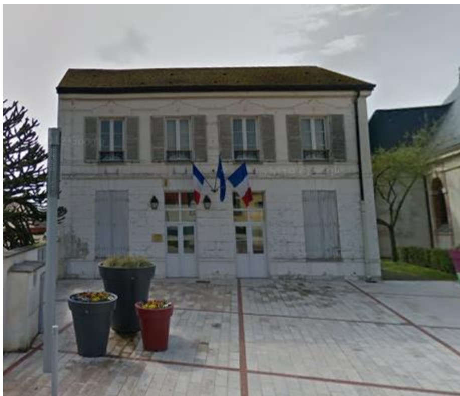
Mairie, construction d'intérêt architectural (au sud de la rue de l'église) : bandeau et encadrement des baies.
