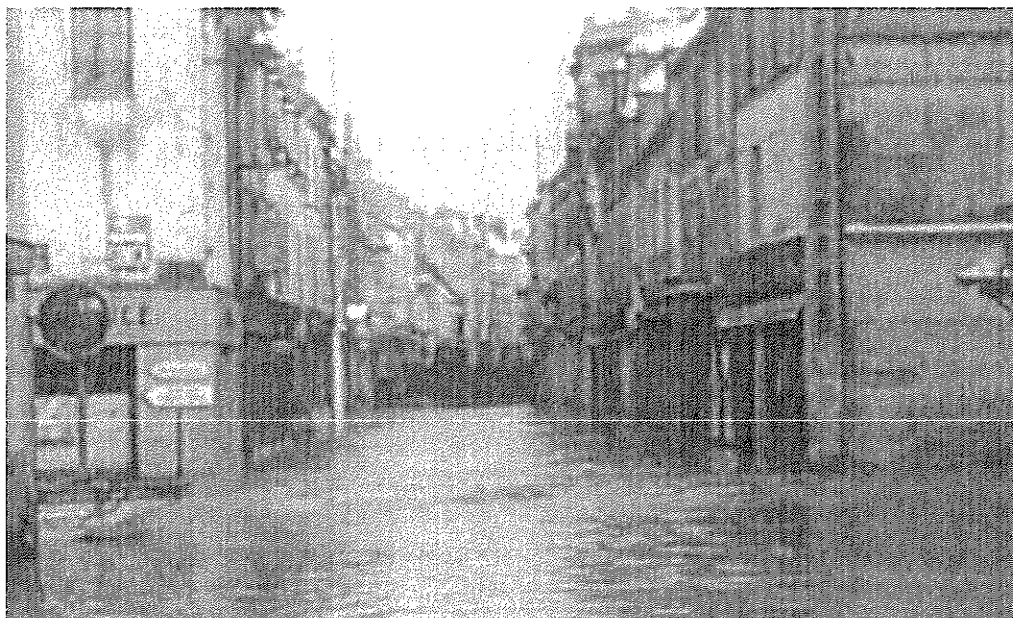
Crue de 1958 dans Coulommiers
