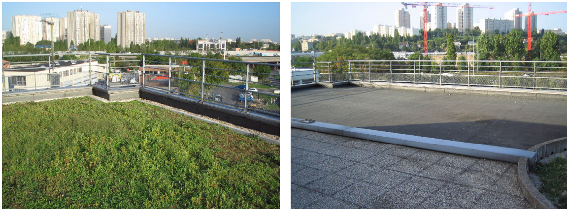
Photo 1 : Exemple de toiture stockante (DEA 93 – Bobigny (93))
