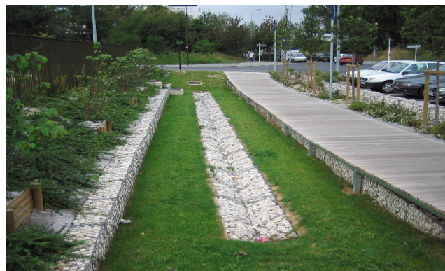
Photo 3 : Exemple de fossé de débordement (Ville de Clichy-sous-Bois (93))
