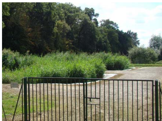
Station d'épuration de Douy
