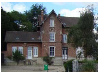
Maison de ferme à DOUY
