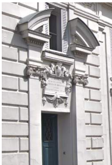
Détail de l'ornementation surmontant la porte d'entrée
