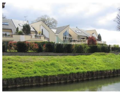
4 – Le talus le long du canal
