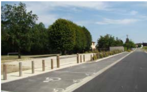
Rue des AUBEPINES
