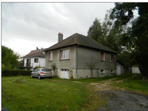
Pavillon construit entre le début des années 1960 et la fin des années 1980
