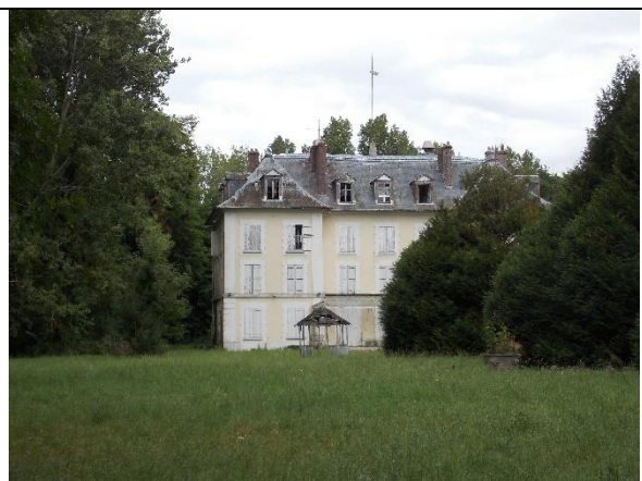
Le corps de bâtiment principal
