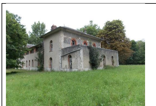
Le bâtiment annexe
