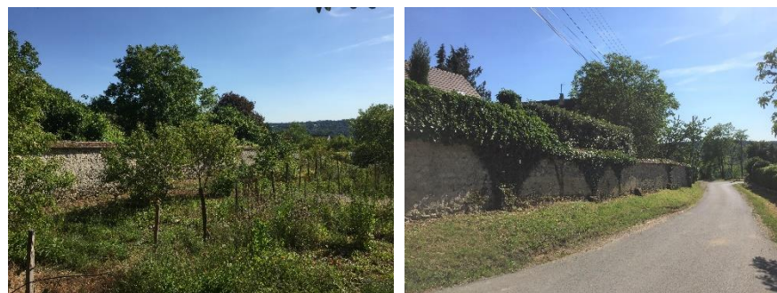
Murs protégés chemin de Samoïs (gauche) et chemin des vaches (droite)
