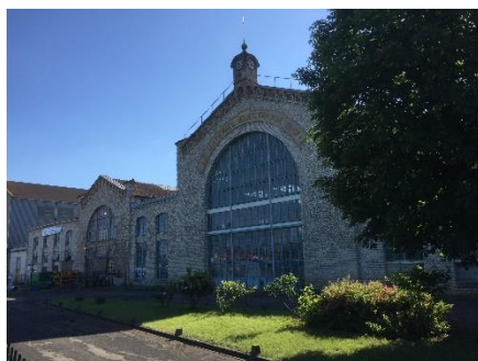
Ancienne usine Schneider
