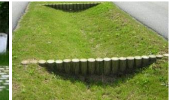
Exemple de noues entrecoupées d'enrochements ou de rondins de bois qui retiennent l'eau dans la pente et évitent ainsi le ruissèlement
