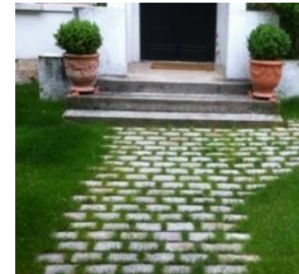
Pavés à joints enherbés
