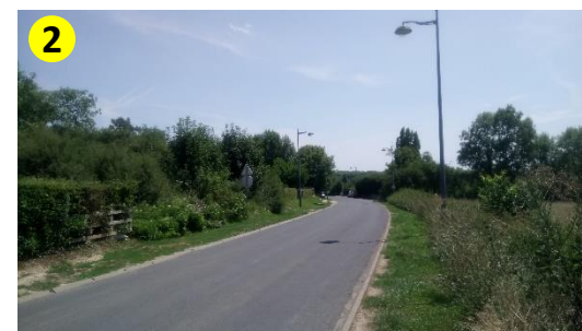
Vue depuis le chemin de la République, en regardant vers le sud
