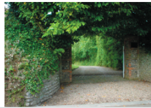
muret de pierres encadrant le portail
