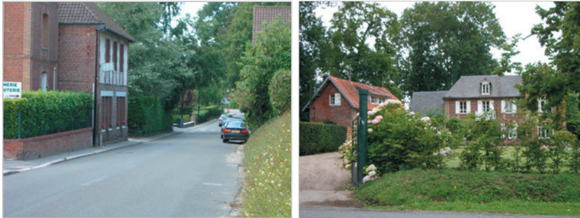
Construction à l'alignement
