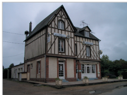
Un étage sur rez-de-chaussée et comble aménagé
