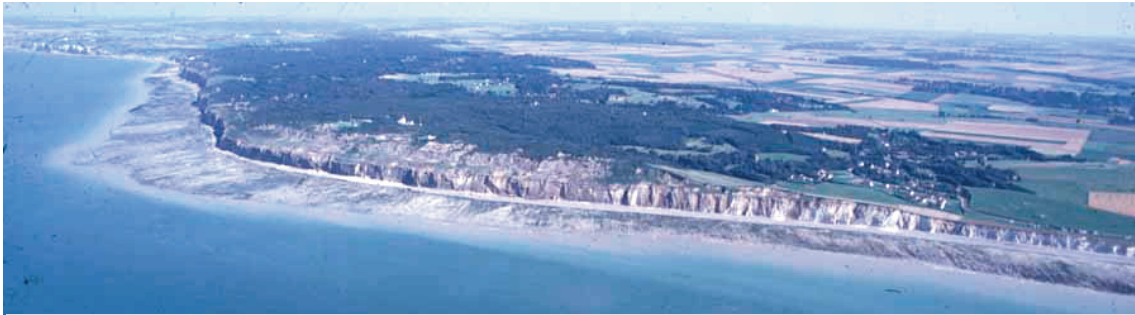
Vue aérienne de la commune : les bois et pâtures bordent le front de mer
