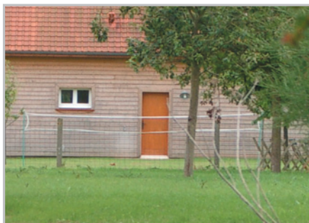
Façade en parement de bois
