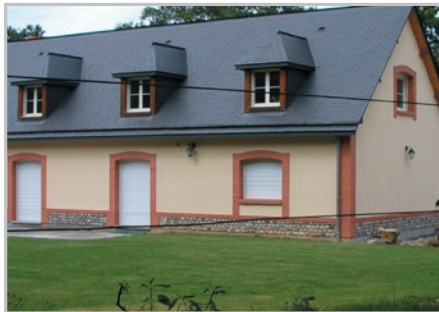
Toiture deux pans
