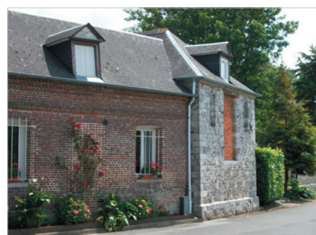
Alignement en façade
