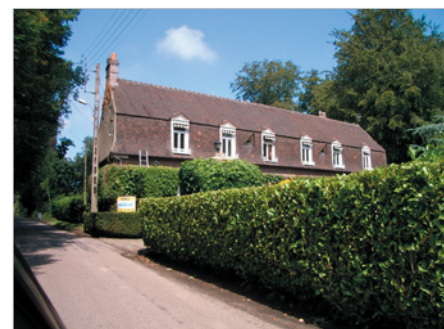
Alignement avec pignon sur rue
