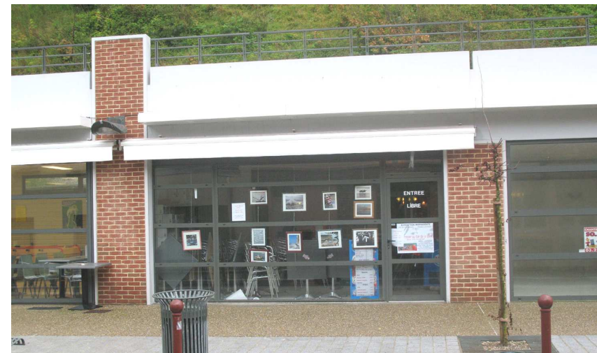
Mauvaise implantation du store : il ne doit pas empiéter sur le trumeau en briques
