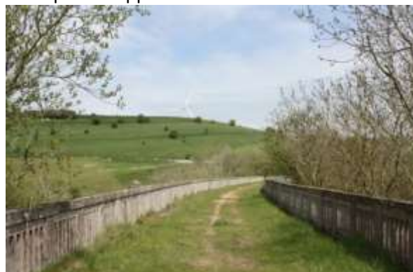
chemin vert du Petit Caux au niveau du viaduc
