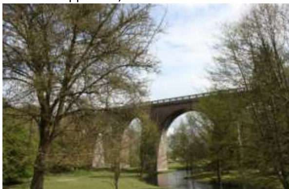
Passage du viaduc au-dessus de l'Yères
