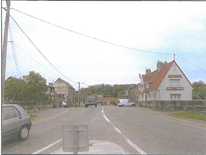
La RD70, entrée de la commune depuis la RN27
