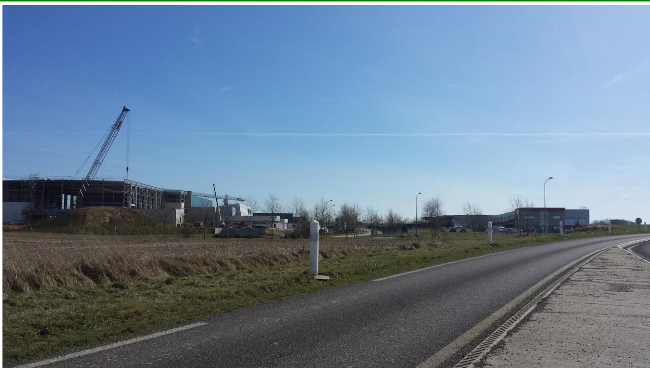
Accès nord à la zone existante (mars 2015)
