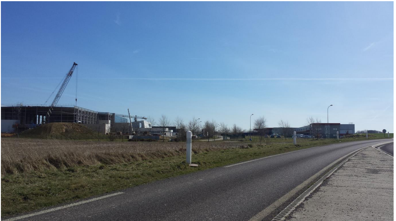
Accès nord à la zone existante (mars 2015)
