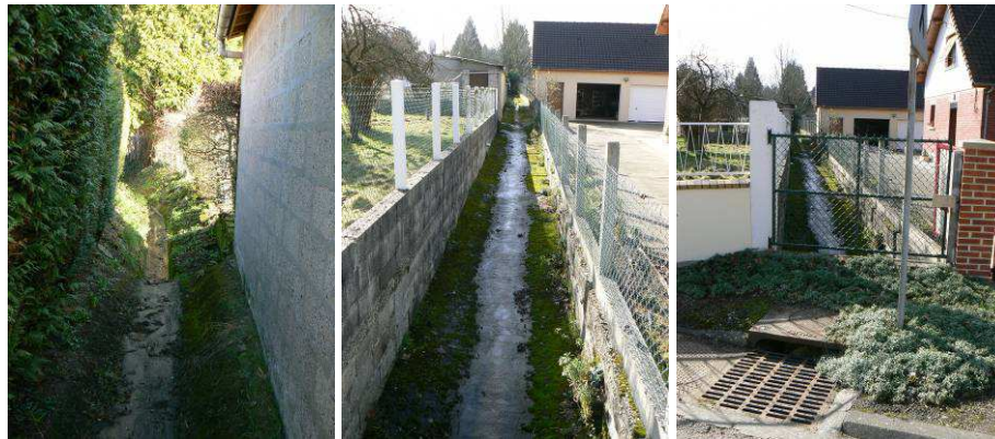
Fossé exutoire du réseau pluvial connecté au thalweg de la rue de la Forêt
