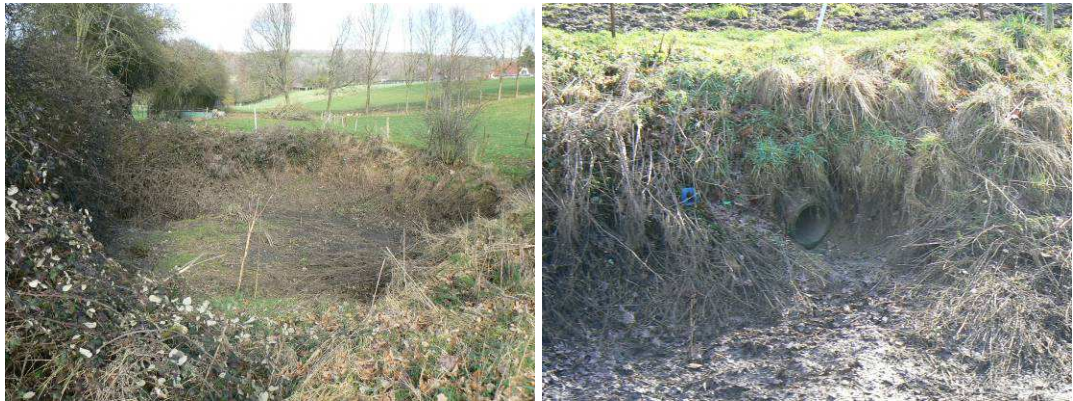
Bassin tampon et collecteur d'entrée
