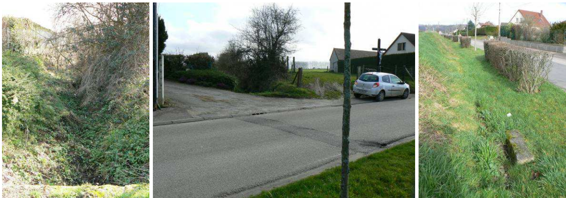
Fossé du Cul-Froid au niveau de la rue du Fresne et connexion bouchée
