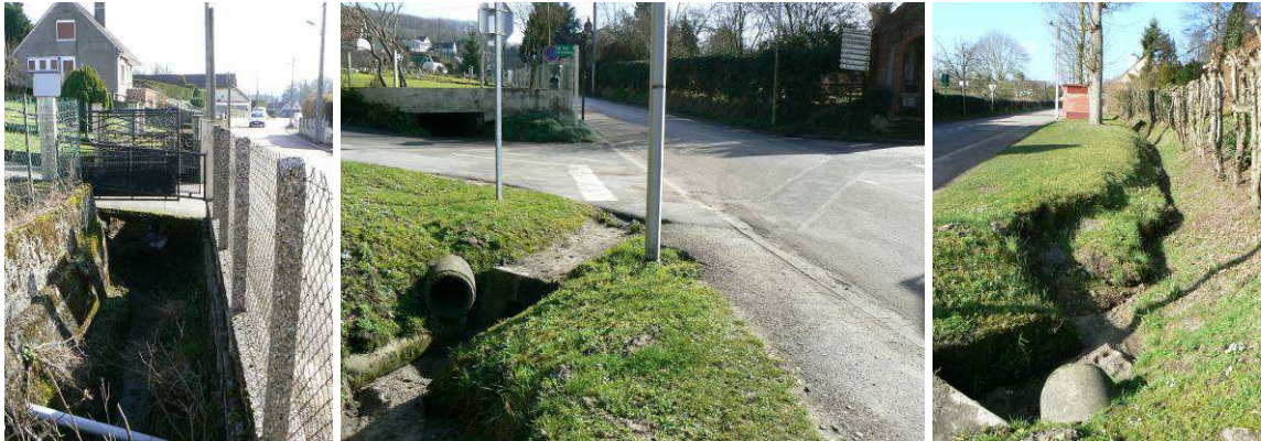
Changements de section et érosion dans les fossés
