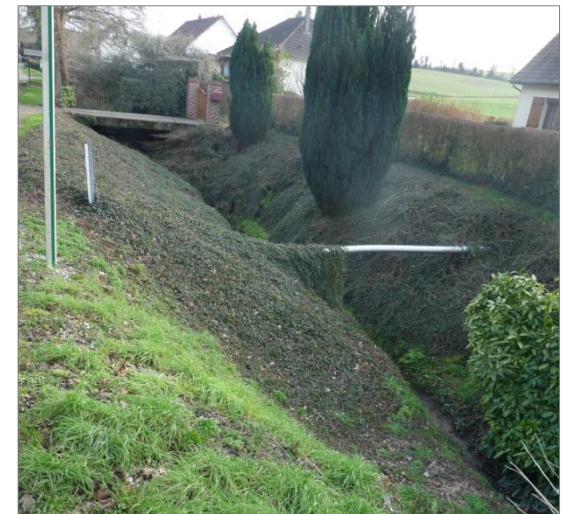
Photo : Fossé des Côtes sous Beaumont (Source : ALISE Environnement)
