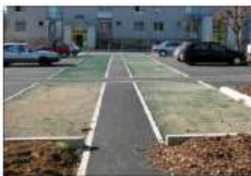
Exemple de parking réservoir à Albi
