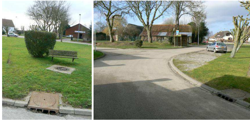
Elements de réseau au hameau du Fresne
