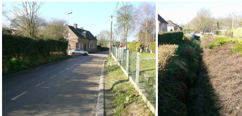
Changements de section et érosion dans les fossés
