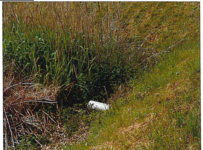
Rejet dans la lagune d'infiltration.
