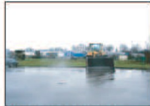
4: Extérieur de l'entreprise SN Sodima
