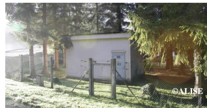
Photo : Captage sur la commune de LA RUE SAINT PIERRE
