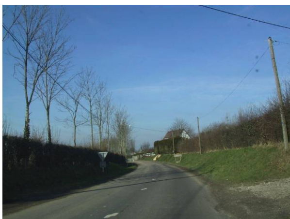
Le long de la rue de la forge
