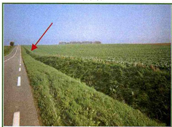
Fossé le long de la RD 928 pouvant déborder et inonder la chaussée
