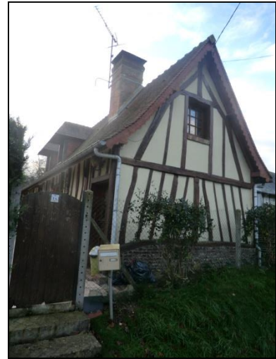
Construction à pan de bois
