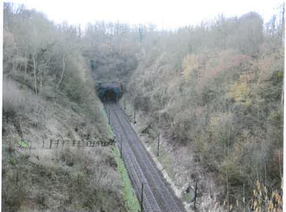
vue sur l'entrée du tunnel ferroviaire du petit Pissy-Pôville depuis la route départementale 47
