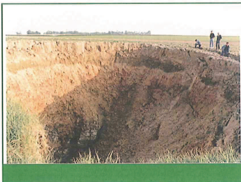
Photo 1 : Effondrement d'une chambre de marnière
